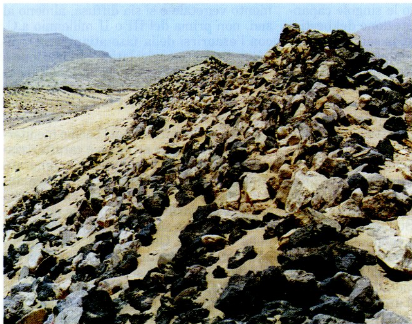
Fig. 8 - L'antico imponente canale di adduzione delle acque derivate dalla diga di Marib (Yemen del nord) costruito a servizio dei mitici giardini della regina di Saba nel periodo compreso tra il 2000 e il 750 a.C. È chiaramente visibile uno degli argini in terra rivestito da massi rocciosi. L'altro si nota in secondo piano in alto a sinistra della foto.
